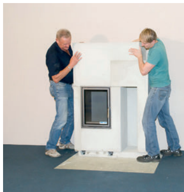
Jednotlivé díly stačí poskládat dle přiloženého návodu. Upevněte akrylátovým lepidlem. (4 + 5)
